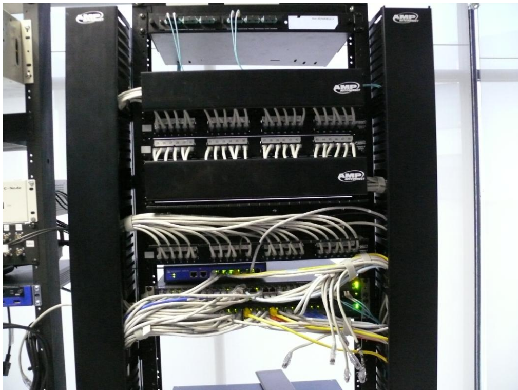
Site Principal. Detalle.
